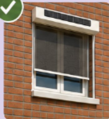
Wél tussen het metselwerk
